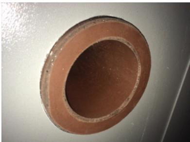
*Unbelegtes Kabel- und Rohrschott mit 100 mm Durchmesser*
