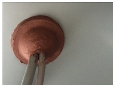
*Abdichtung des Schottsystems mit Brandschutzmasse*
