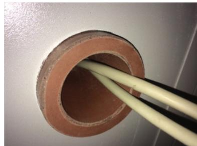
*Einführung der Kabel durch das Schottsystem*
